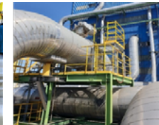
K-301, 302 점검용 플랫폼 설치
