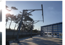
차량 작업용 안전거치대 설치
