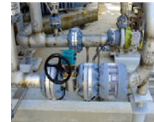
HCI 전 라인 비산방지 커버 설치
